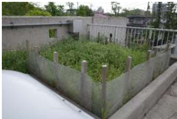
屋上に整備中の飼養施設
