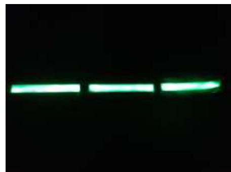
安全対策のために取り付けました手すりの蓄光テープ
