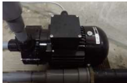
交換したポンプ
