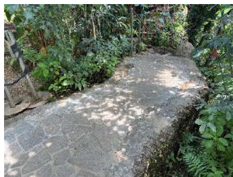
築山床面の舗装
