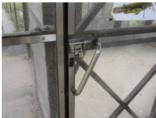
昆虫ドーム・取手の設置
